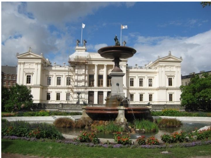
HAUPTVERWALTUNGS- GEBÄUDE DER UNIVERSITÄT
